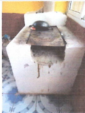
Foto 4: Reparación de estufa rural, plancha y accesorios y suministro de azulejo
