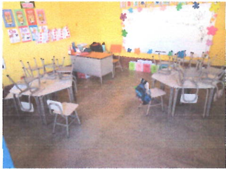
Foto 2: Sustrucción de acabado liso, por piso cerámico en aula, corredor y servicios sanitarios
