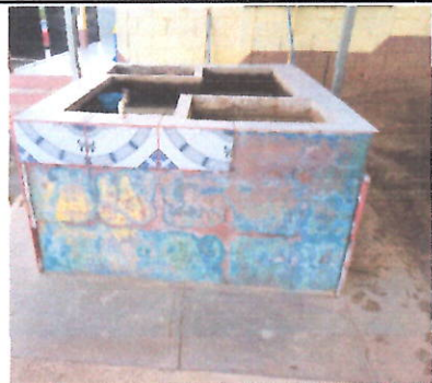
Foto 6: Reparación de pila, sustitución de azulejo
