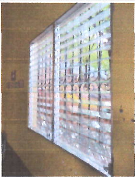
Foto1: Sustrucción de ventanas; sistema de apertura: Corredizas, Perfiles color blanco estandar, Material del marco: PVC Material de la ventana: Vidrio, sellado perimetral.
