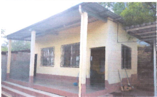
Foto 5: Preparación de la superficie y aplicación de pintura a dos manos, en paredes interiores y exteriores del establecimiento.
